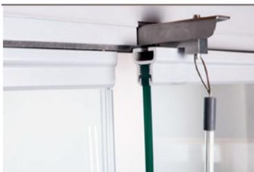
Detalle del cierre superior con el tirador de metacrilato. El sistema estándar cuenta con posición de ventilación.
